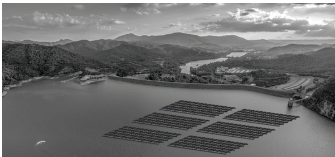
IN EUROPA INIZIANO AD AFFACCIARSI I PRIMI IMPIANTI FOTOVOLTAICI GALLEGGIANTI, CHE RICHIEDONO PARTICOLARI STRUTTURE DI MONTAGGIO. K2 SYSTEM LE HA SVILUPPATE PER UN PROGETTO DA 500 KWP IN OLANDA
