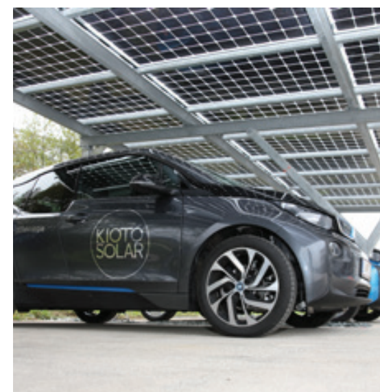
UN ESEMPIO DI PENSILINA FOTOVOLTAICA CON MODULI VETRO VETRO E SISTEMI KEBE PER LA RICARICA DEI VEICOLI ELETTRICI INSTALLATA A POCCHI CHILOMETRI DA SANKT VEIT
