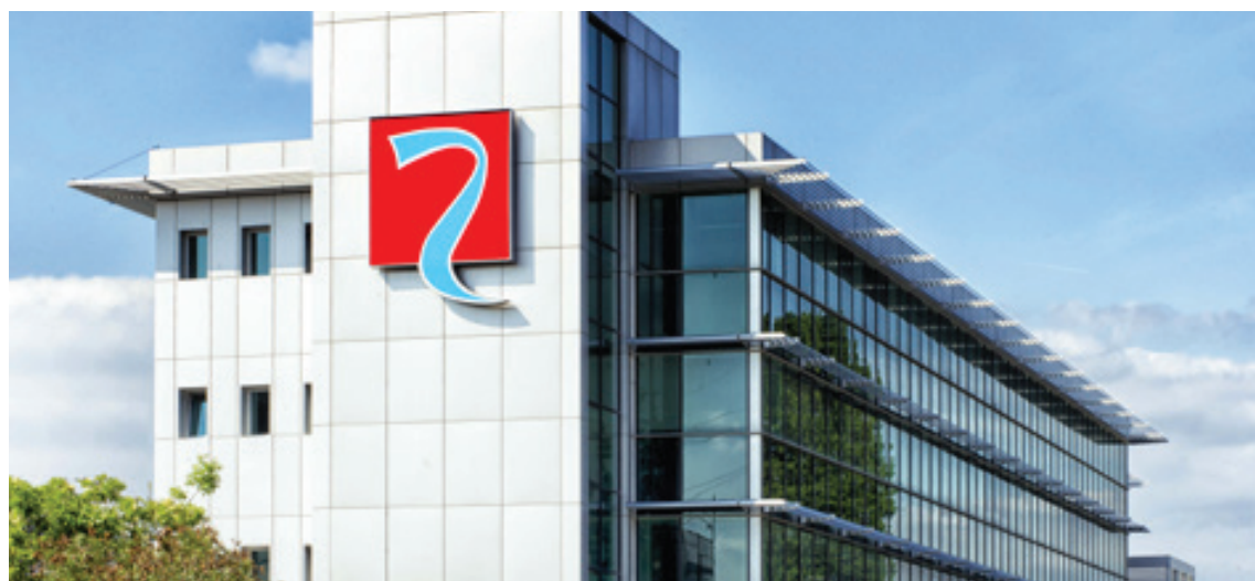
LA SEDE DI RIELLO ELETTRONICA A CORMANO (MI). L'AZIENDA È LEADER STORICA NELLA PRODUZIONE DI GRUPPI DI CONTINUITÀ E IN AUTUNNO LANCIERÀ UNA NUOVA GAMMA DI INVERTER PER IL SEGMENTO RESIDENZIALE
