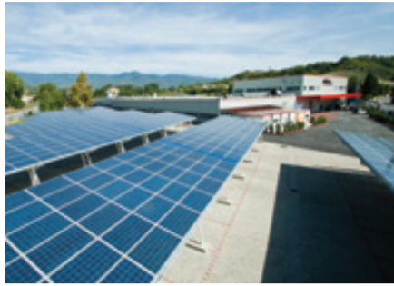
La sede produttiva di ABB a Terranuova Bracciolini (AR)
