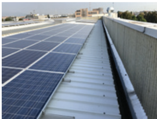
L'IMPIANTO, REALIZZATO NEL 2011, È COSTITUITO DA 840 MODULI DA 230 WP ORA ALLACCIATI A DUE INVERTER DI STRINGA SOLAREEDGE E MONITORATI COSTANTEMENTE DA OTTIMIZZATORI DI POTENZA
