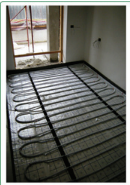
Fig. 3. Il riscaldamento a pannelli radianti a pavimento.
