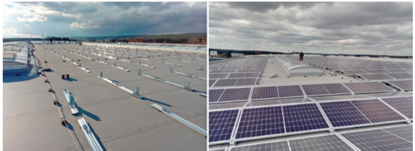
IL TETTO PIANO HA UN IMPIANTO FOTOVOLTAICO CON UN TOTALE DI 1.168 MODULI SOLARI E UNA POTENZA DI 367,92 KWP. IL SISTEMA DI MONTAGGIO ADATTO È LA D-DOME V
