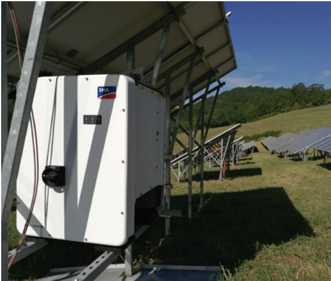
LA SOSTITUZIONE HA RIGUARDATO L'INSTALLAZIONE DI 17 INVERTER DI STRINGA SMA CORE1 E ALTRI DUE INVERTER TRIFASE SEMPRE A MARCHIO SMA
