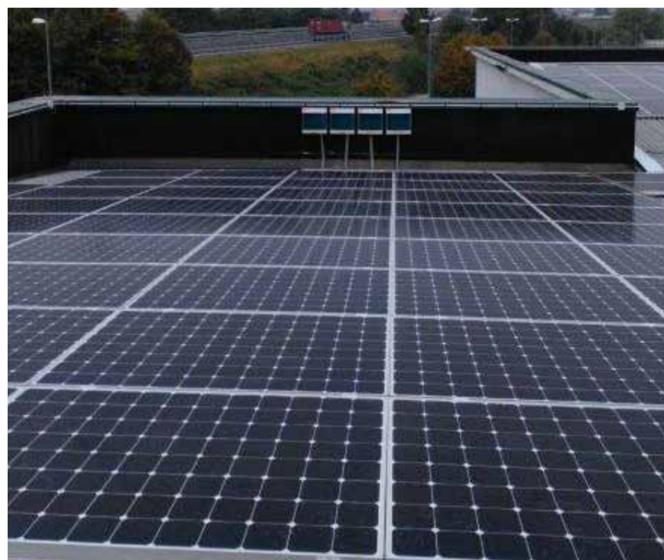
L'INSTALLAZIONE CONTA 479 MODULI SUNPOWER, ALLACCIATI A 7 INVERTER TRIFASE ABB
