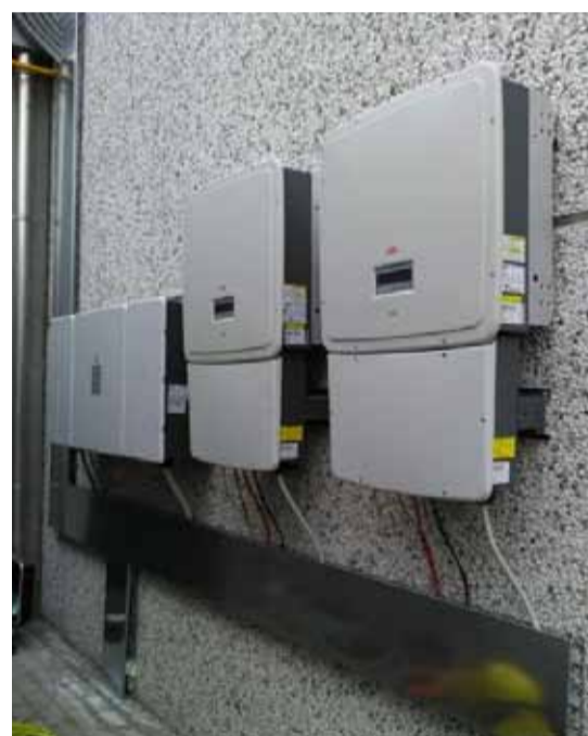
L'INSTALLAZIONE CONTA 479 MODULI SUNPOWER, ALLACCIATI A 7 INVERTER TRIFASE ABB
