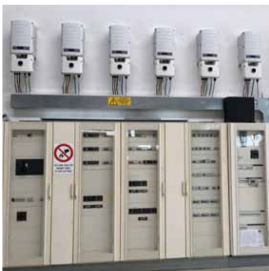
I MODULI SONO ALLACCIATI A SETTE INVERTER SOLAREEDGE E MONTATI SU SISTEMI DI SOSTEGNO RODIGAS
