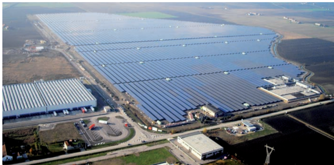
L'impianto di San Bellino (RO), per una potenza di 70 MW, conta 35 MW di inverter Ingeteam e 35 MW di inverter Bonfiglioli
