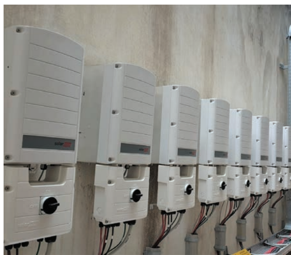
L'IMPIANTO CONTA 550 MODULI MONOCRISTALLINI SUNPOWER DA 360 WP ALLACCIATI A INVERTER TRIFASE SOLAREEDGE CON OTTIMIZZATORI DI ENERGIA A BORDO
