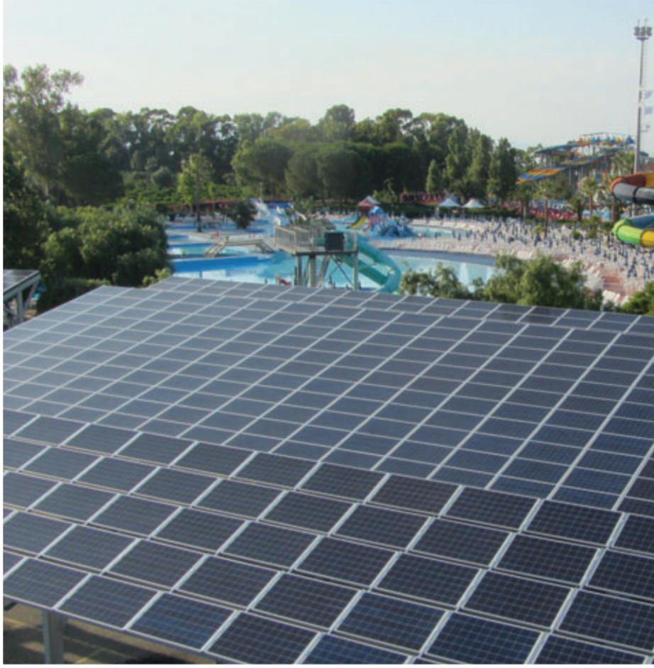
Impianto da 700 kw realizzato a Giugno 2015 con moduli WRS250W – ST60C presso l'Acquapark Odissea 2000 di Rossano (CS) a cura dell'impresa edile Galluzzo
