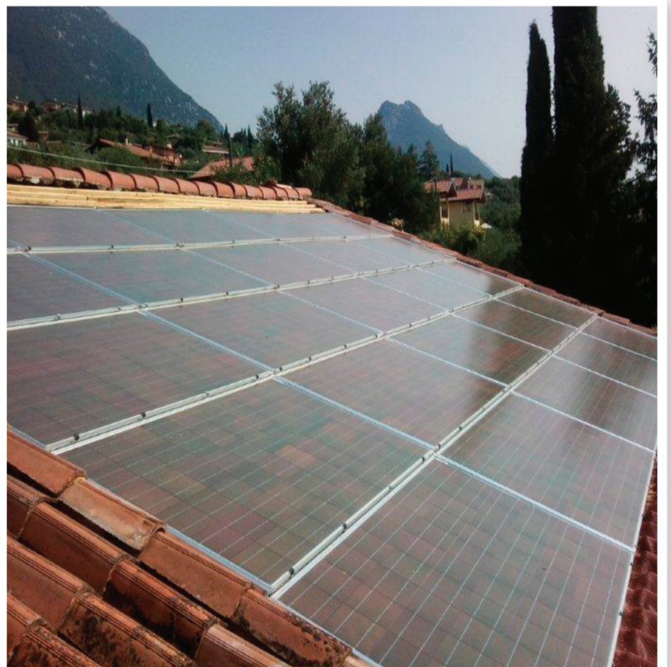
Impianto da 5,25 kw con moduli Red Line (celle colorate) a Toscolano Maderno (BS) sul Lago di Garda
