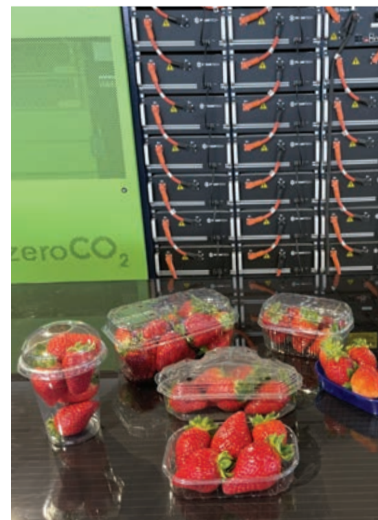
ENERGY HA FORNITO IL SISTEMA DI STORAGE ZEROCO2 XL DA 1,2 MWH CON 1,2 MW DI POTENZA DI CARICA E SCARICA
