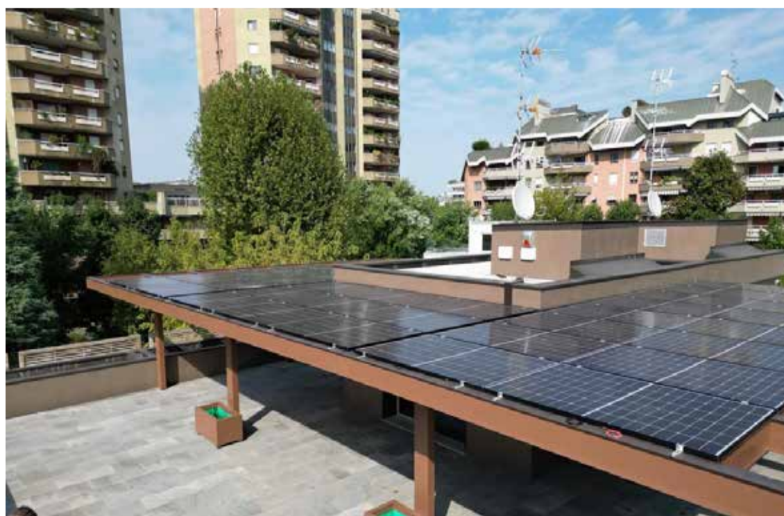
LA SCELTA DI REALIZZARE UN PERGOLATO SU CUI INSTALLARE I MODULI È STATA DETTATA ANCHE DAL FATTO CHE IL PALAZZO È CIRCONDATO DA GRANDI ALBERI CHE AUMENTAVANO IL PROBLEMA DELL'OMBREGGIAMENTO. IL MONTAGGIO DEI PANNELLI SU UNA STRUTTURA A CIRCA TRE METRI DAL TETTO AIUTA L'IMPIANTO A PERFORMARE MEGLIO
