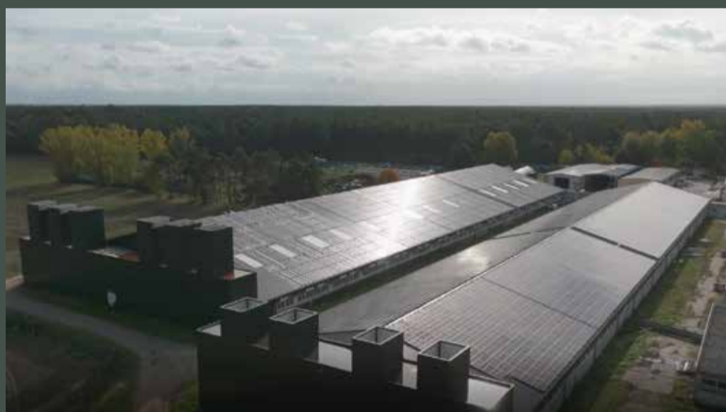
AEROCOMPACT HA FORNITO IL SUO SISTEMA A BINARI COMPACTMETAL PER L'INSTALLAZIONE DI UN IMPIANTO DA 1,8 MWp SULLE COPERTURE DI DUE CAPANNONI IN GERMANIA
