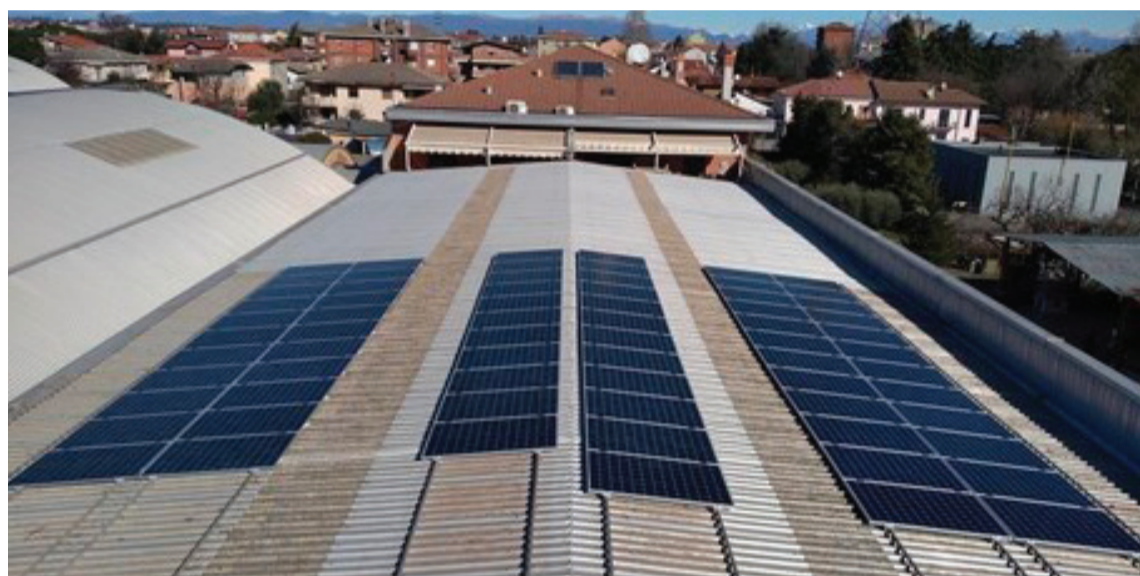
ECOTECHNO IMPIANTI HA SOSTITUITO TUTTI I MODULI PRESENTI E HA INSTALLATO 69 PANNELLI AD ALTA EFFICIENZA SUNPOWER MAXEON DA 360 W. L'AZIENDA SI OCCUPERÀ ANCHE DI MONITORAGGIO, MANUTENZIONE E GESTIONE DELLE PRATICHE BUROCRATICHE
