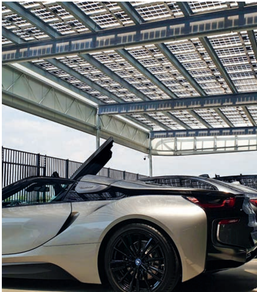
NEL SEGMENTO COMMERCIALE E INDUSTRIALE VA CONSIDERATA LA SCELTA DI UTILIZZARE LA TECNOLOGIA BIFACCIALE SU PENSILINE NELLE AREE DI PARCHEGGIO DELLE AZIENDE LADDOVE I TETTI NON SIANO PREDISPOSTI E SU COPERTURE DI FABBRICATI INDUSTRIALI DI GRANDI DIMENSIONI
