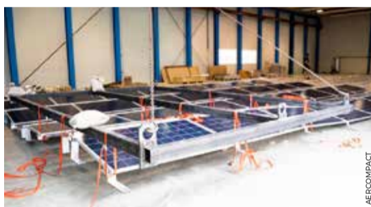
VERIFICA DEL CARICO DI ASPIRAZIONE DEL NOSTRO SISTEMA DI MONTAGGIO COMPACTFLAT S EST/OVEST
