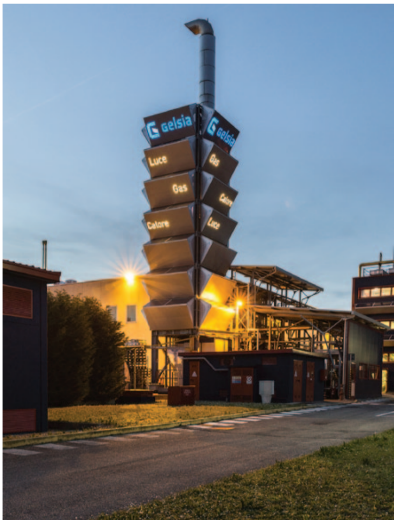
UN'INSTALLAZIONE FV DI SOLAR RETROFIT RICOPRE LE PARETI DELLA TORRE DI ESPULSIONE VAPORE DELL'AZIENDA GELSIA A SEREGNO (MB). GRAZIE ALL'INCLINAZIONE DI 30° LA RESA DEI PANNELLI È IDENTICA A QUELLA DEGLI IMPIANTI "TRADIZIONALI"
